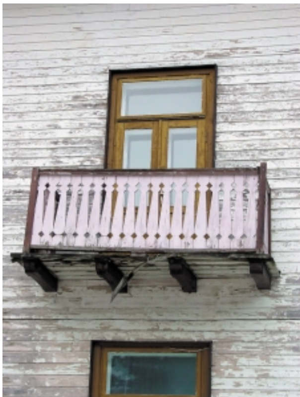
Ryc. 6. Rymanów Zdrój. Willa „Leliwa”, fragment elewacji z balkonem
