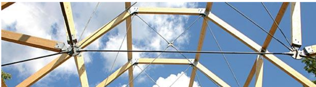
Fot. 8. Kościół Moelven w Łodzi - połączenie konstrukcji z drewna klejonego i cięgien systemowych.
